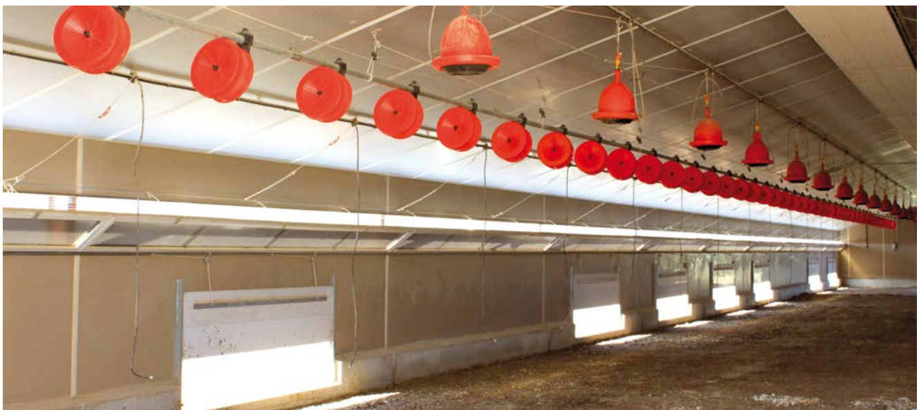
Un nettoyage drastique du bâtiment en cours de vide sanitaire permet de limiter la contamination par les coccidies en début de lot.
