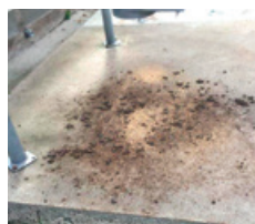
Fuite d'aliment sous silo : 1. Étanchéité du circuit de distribution d'aliment à vérifier. 2. Risque élevé rongeurs/oiseaux/ insectes.
