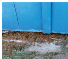
Défaut d'étanchéité en bas de portail : risque d'entrée de nuisibles contami- nés. En cas de lot contaminé : risque de contamination de l'environnement extérieur avec persistance du germe.
